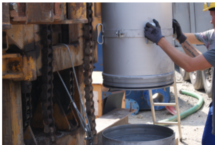
Bild 1: Einbau eines Vollwandrohres DN500 mit ZSM-Verbindung
